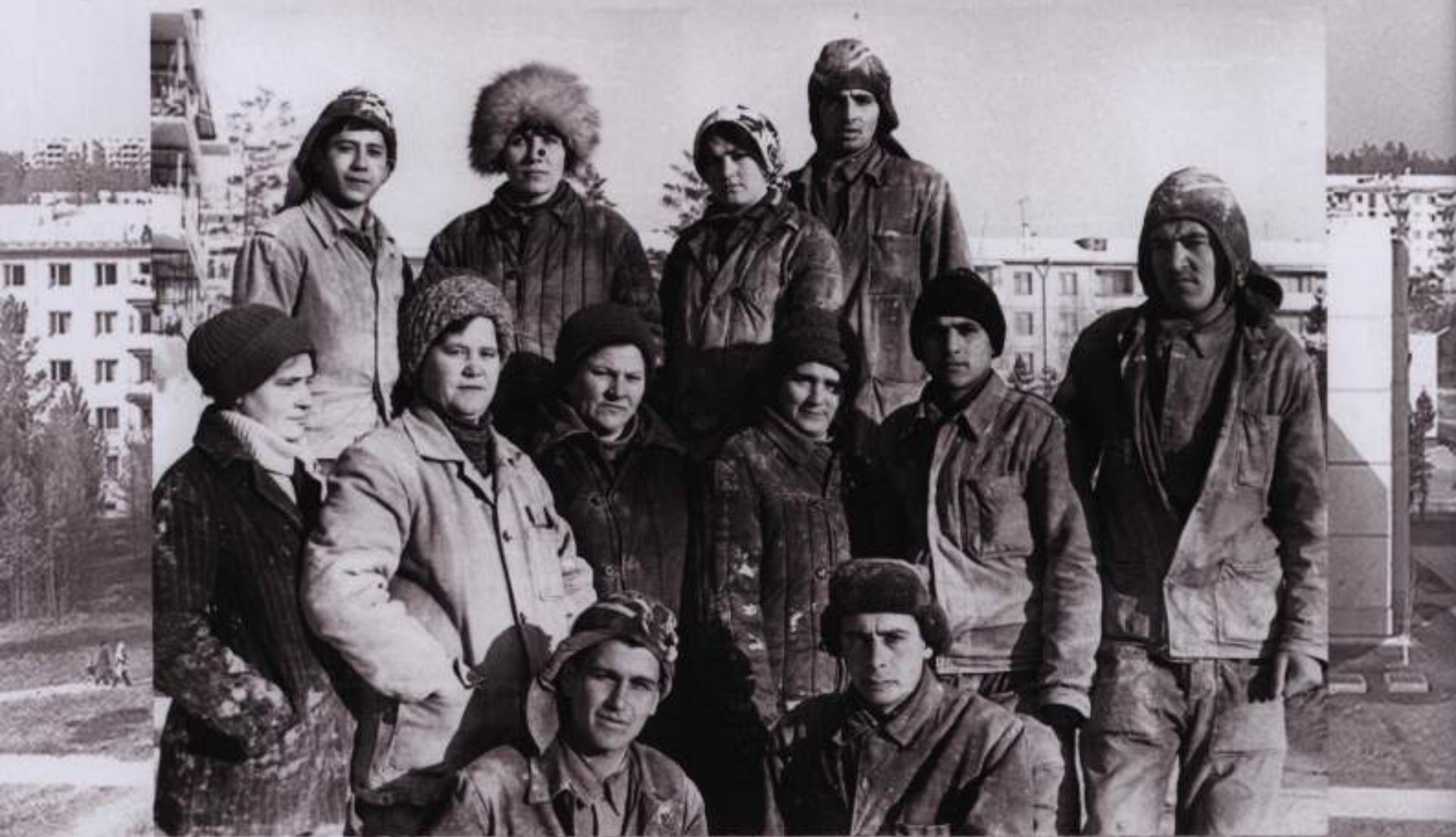
Бригада Мананковой Валентины. Строительство детского учреждения № 21 (1981 год)
